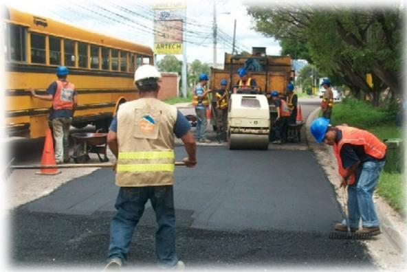
Los objetivos primordiales perseguidos en este importante programa de inversiones para **“Bacheo Puntual”** será el de ejecutar obras de mantenimiento rutinario de calidad, que incluye la reparación de baches de relativo menor tamaño empleando mezcla asfáltica en caliente, así como el sostenimiento de los trabajos de mantenimiento periódico y rehabilitación realizados durante los años 2009 y 2010.
