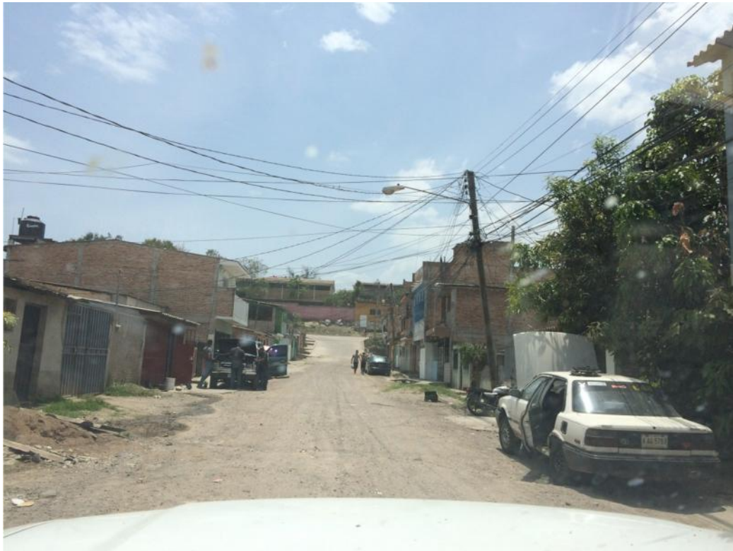
Estado actual de la calle
