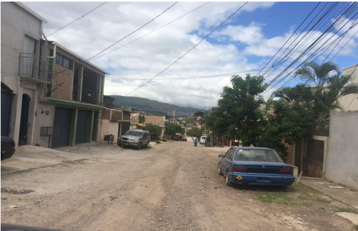
Vista de calle a pavimentar
