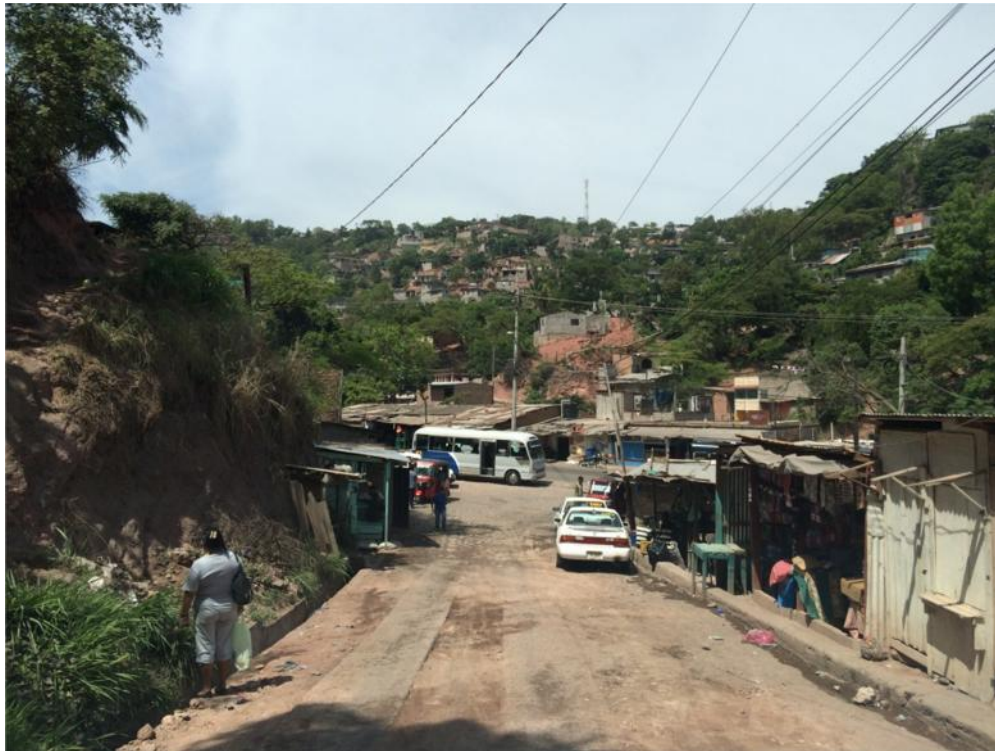
VISTA PANORAMICA DEL INICIO DEL PROYECTO
