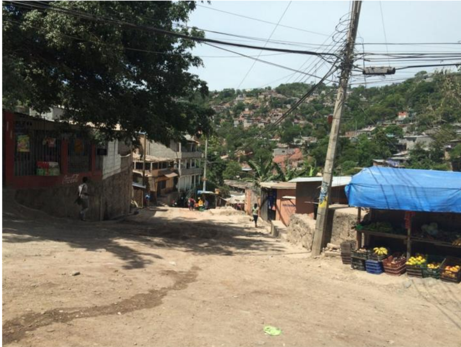
VISTA PANORÁMICA DE TRAMO A PAVIMENTAR
