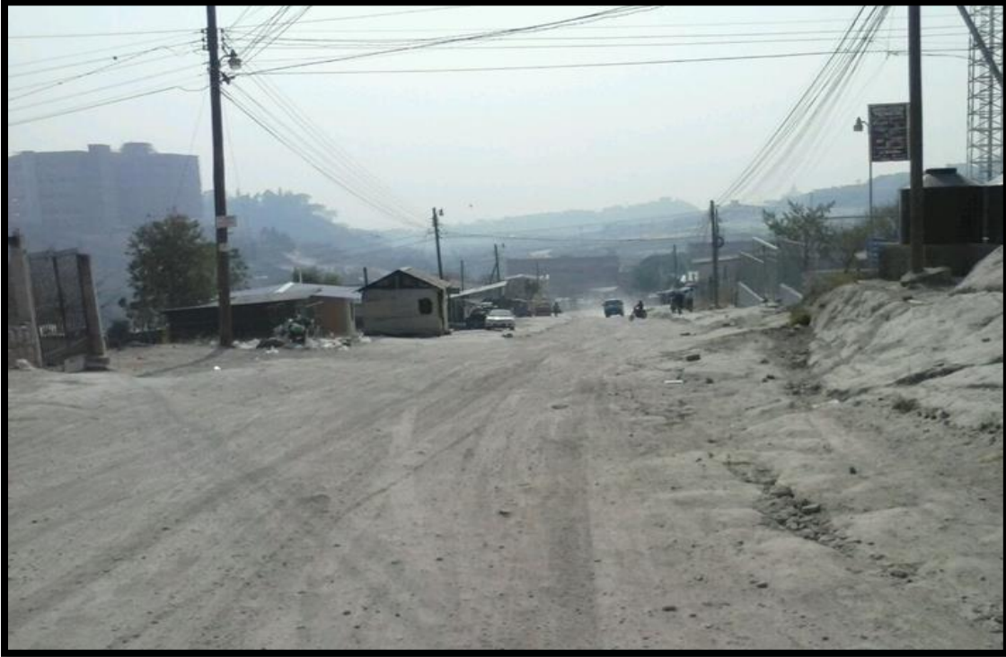
VISTA DEL INICIO DEL TRAMO A PAVIMENTAR
