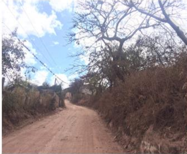
VISTA PANORÁMICA DE CALLES A REPARAR EN COLONIA LOS PERIODISTAS
