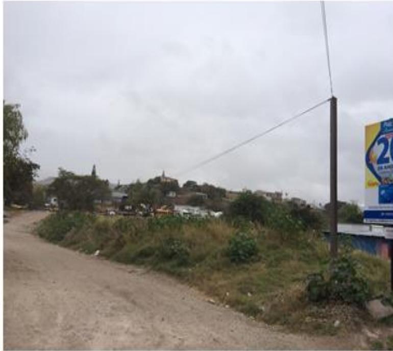
VISTA DE CALLE A REPARAR EN COLONIA LOS PERIODISTAS
