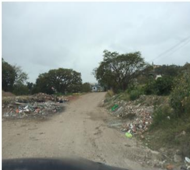
VISTA ACTUAL DE CALLE A REPARAR EN COLONIA LOS PERIODISTAS
