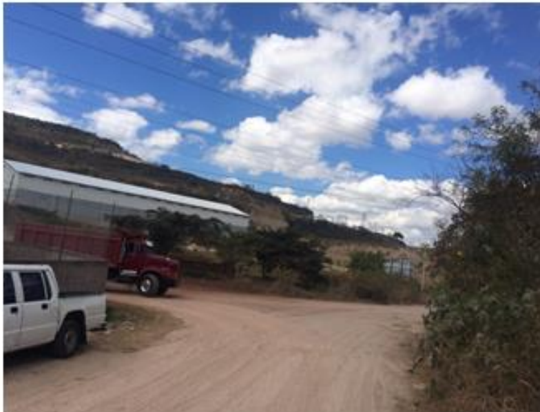
VISTA DE CALLE QUE REQUIERE BALASTADO EN ALDEA CAÑADA
