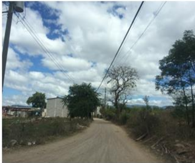
VISTA DE CALLE QUE REQUIERE BALASTADO EN ALDEA CAÑADA
