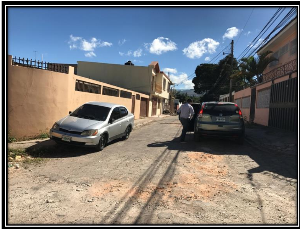
Foto No. 2: Vista donde se desmontará el adoquín
