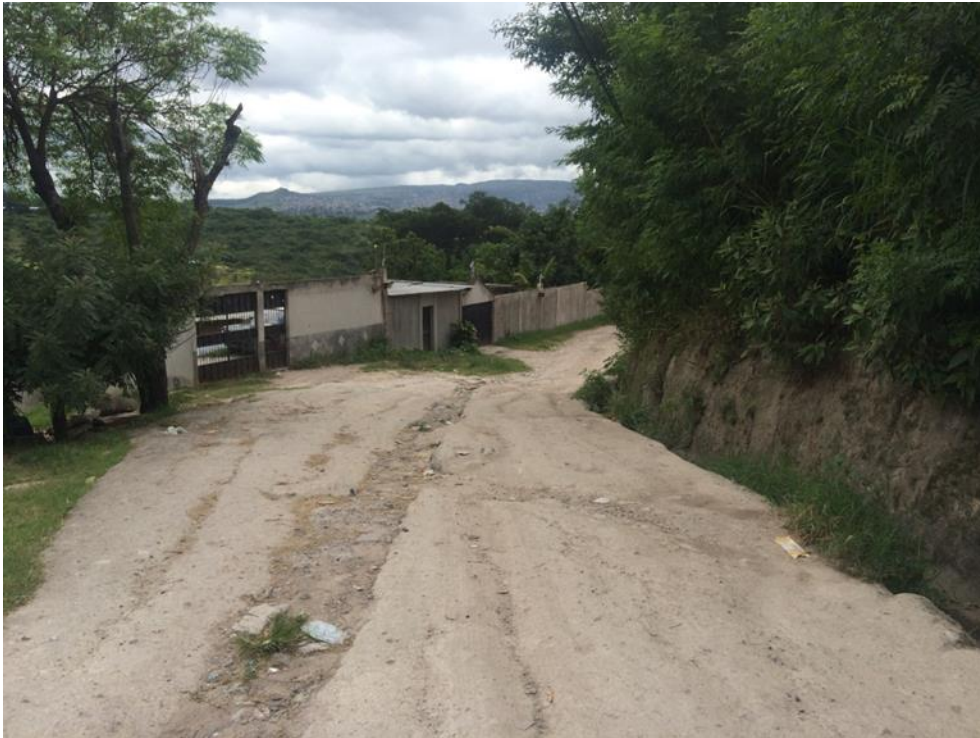
Continuación de calle a pavimentar con concreto hidráulico
