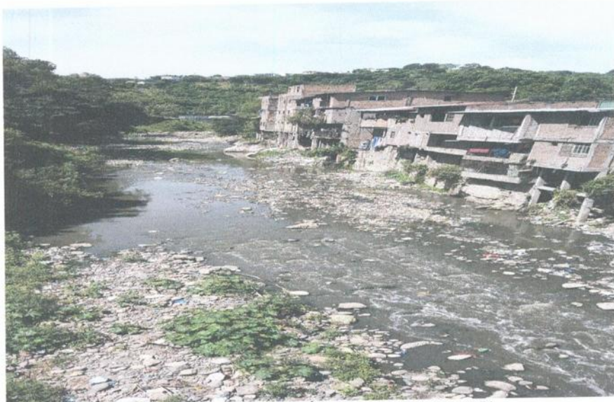
VISTA PANORAMICA, ATRÁS DEL IHSS LA GRANJA
