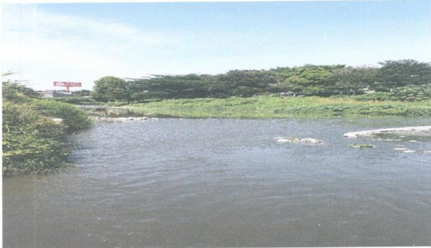
INICIO DEL TRAMO A CANALIZAR
