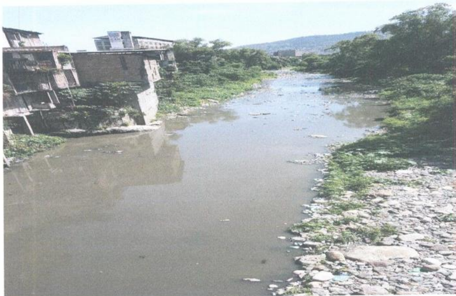
PODEMOS VER LA SUCIEDAD PRESENTE EN EL TRAMO A CANALIZAR
