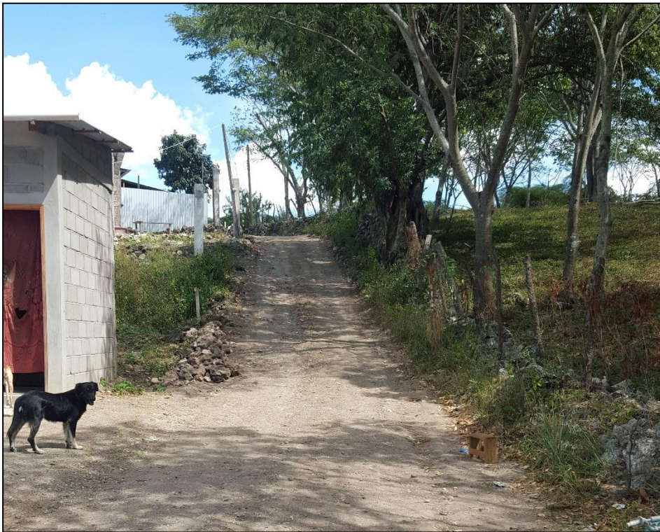
Foto 4. Vista panorámica donde se construirán las cunetas
