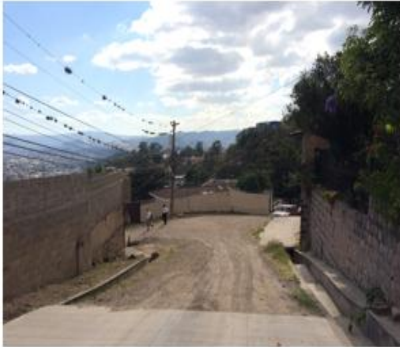
1. VISTA DONDE TERMINA PAVIMENTO EXISTENTE E INICIA EL NUEVO
