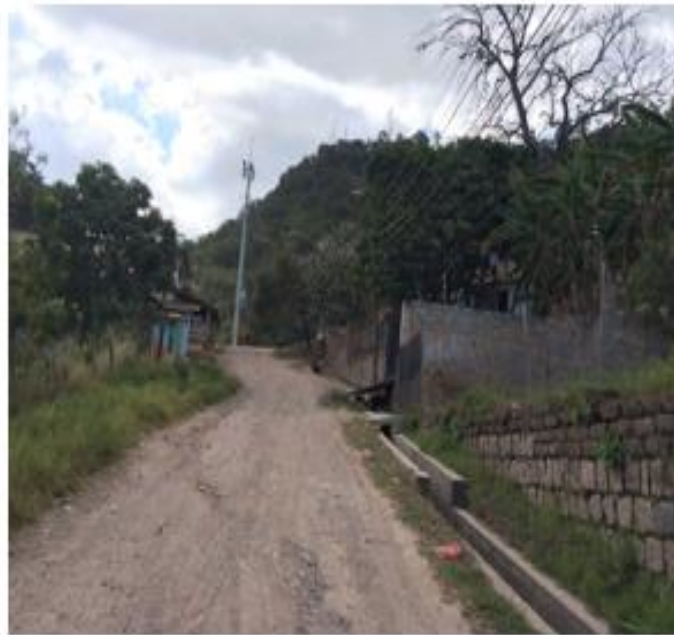
4. VISTA PANORAMICA DE CALLE A PAVIMENTAR
