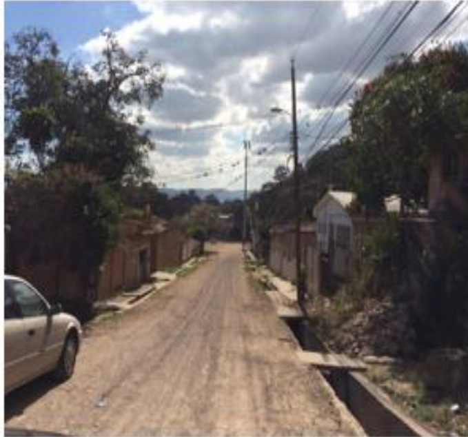
3. VISTA PANORAMICA DE CALLE A PAVIMENTAR
