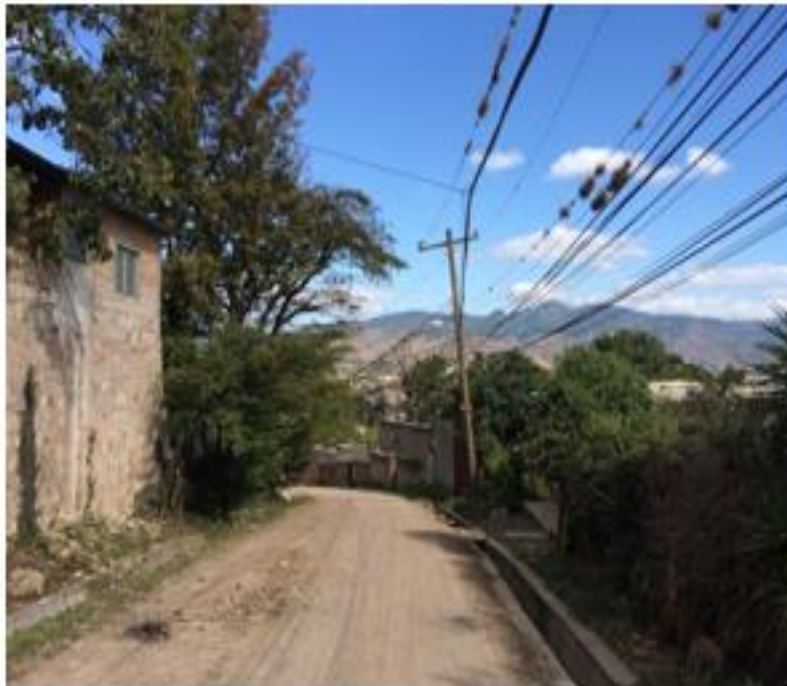
2. VISTA PANORAMICA DE CALLE A PAVIMENTAR
