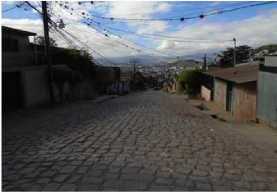
VISTA DE CALLE A PAVIMENTAR CON WHITE TOPPING
