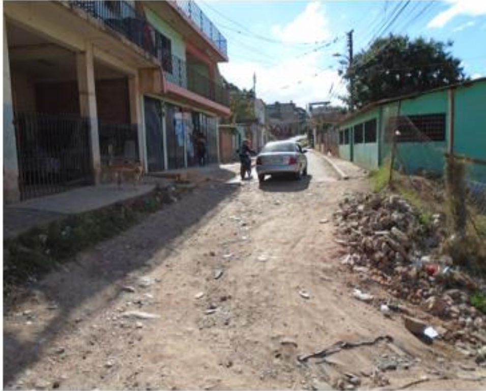
VISTA DE CALLE A PAVIMENTAR CON CONCRETO HIDRÁULICO
