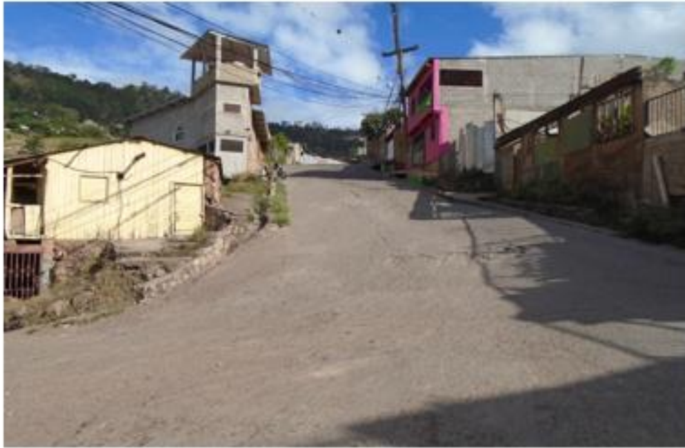
PANORÁMA DE CALLE A PAVIMENTAR CON CONCRETO HIDRÁULICO
