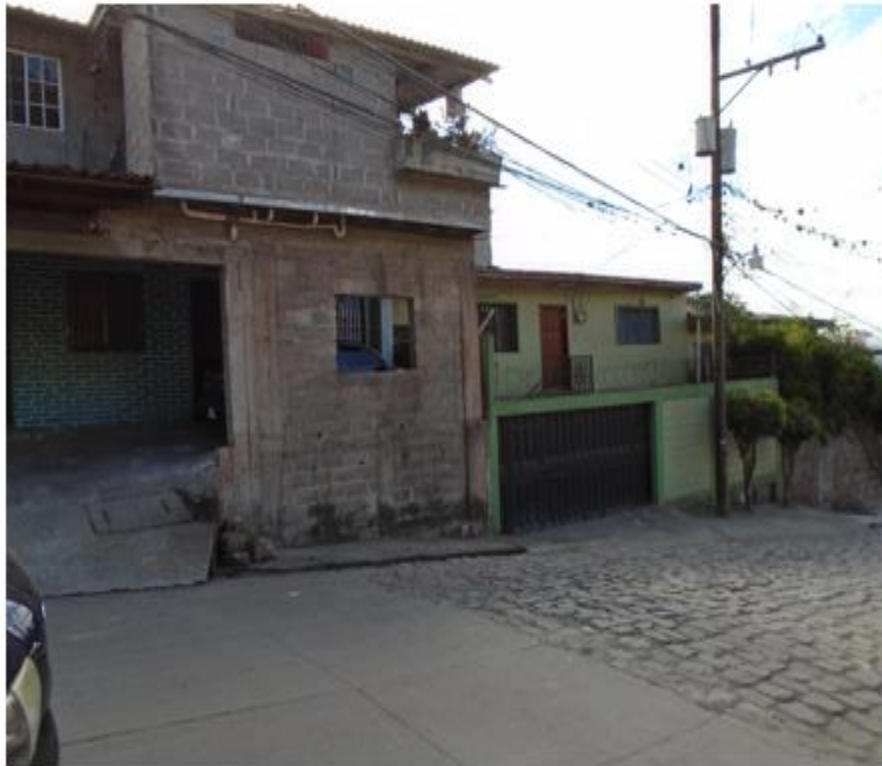
VISTA DE LA CALLE DONDE SE HARÁ LA LOSA DE TRANSICIÓN
