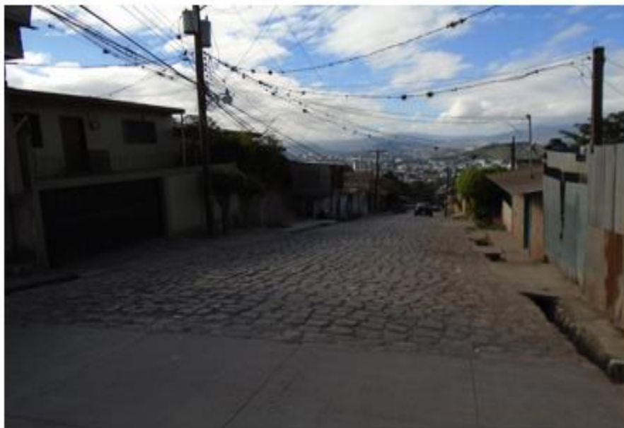
VISTA DE CALLE A PAVIMENTAR CON WHITE TOPPING
