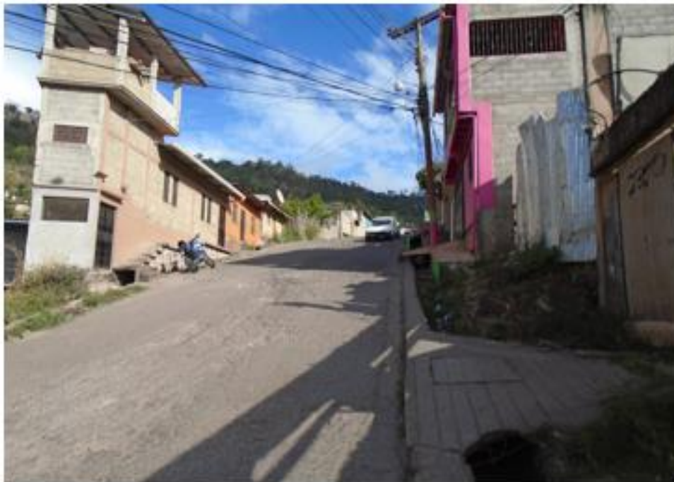
VISTA DONDE SE HARÁ LA DEMOLICIÓN DE ELEMENTOS DE CONCRETO
