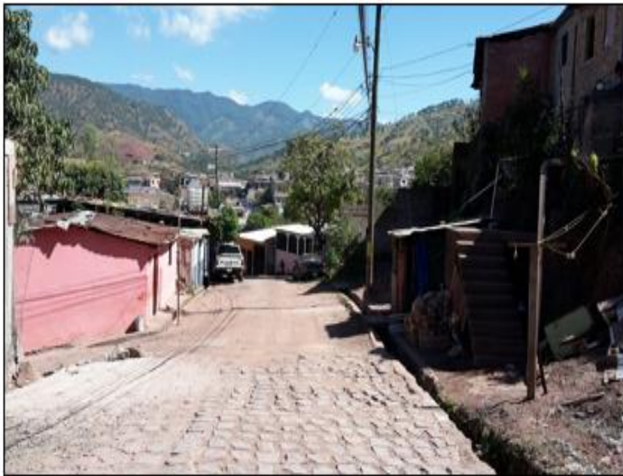
FINAL TRAMO 1 PAVIMENTACIÓN CON WHITE TOPPING
