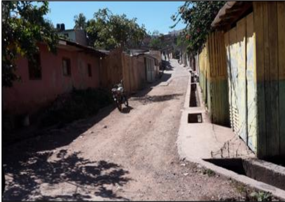
INICIO TRAMO 2 PAVIMENTACIÓN CON CONCRETO HIDRÁULICO
