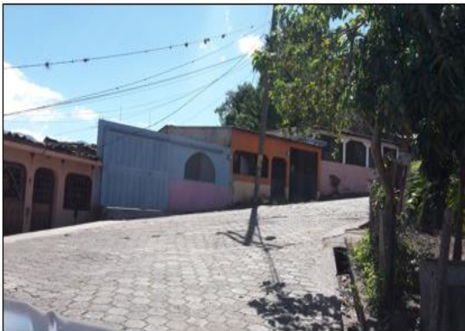
FINAL TRAMO 2 PAVIMENTACIÓN CON CONCRETO HIDRÁULICO
