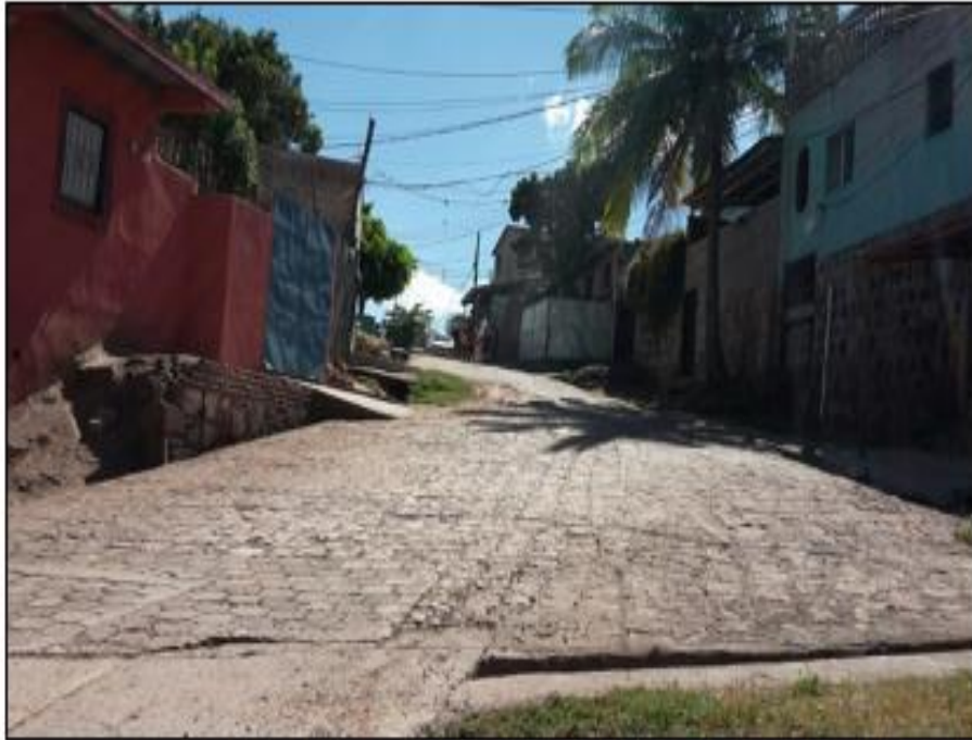
INICIO TRAMO 1 PAVIMENTACIÓN CON WHITE TOPPING
