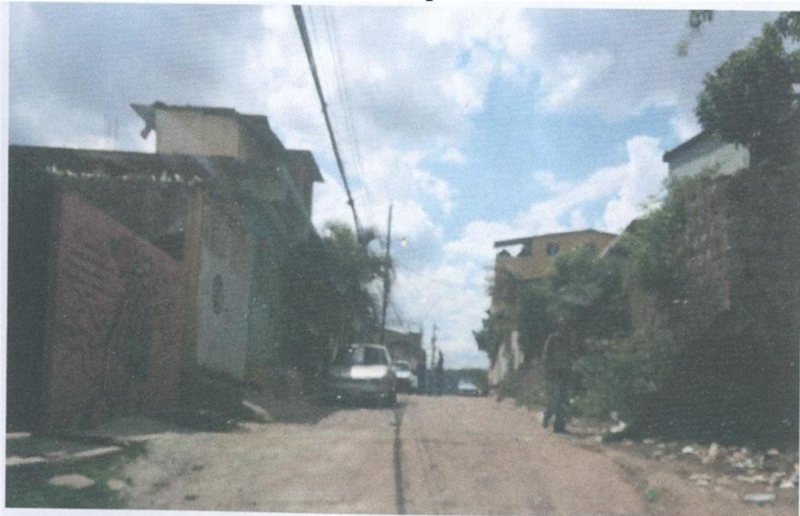
Final de calle a pavimentar
