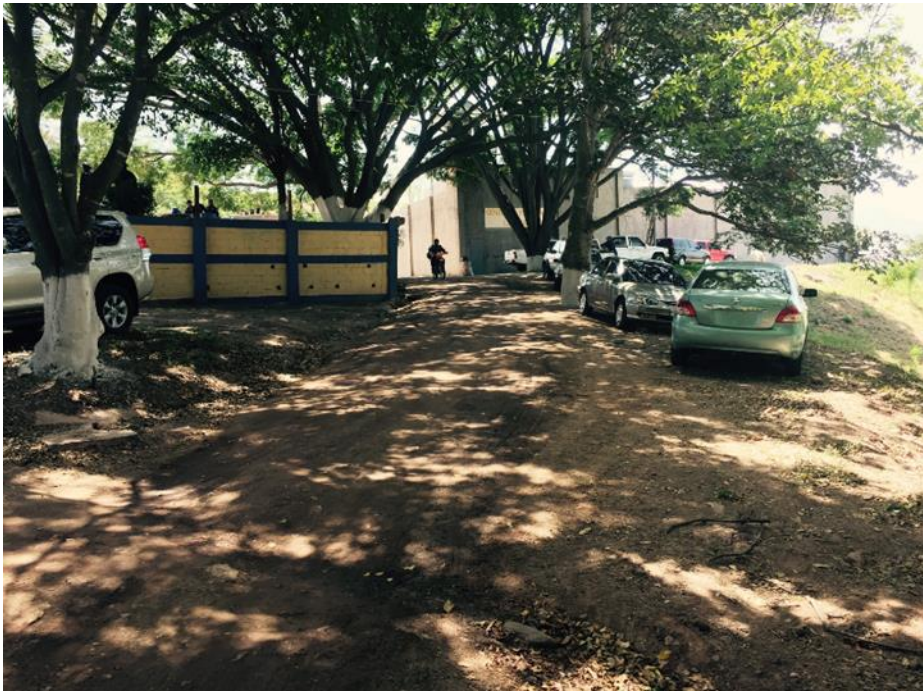
Foto 3. Vista calle a reparar en plantel “COBRAS”
