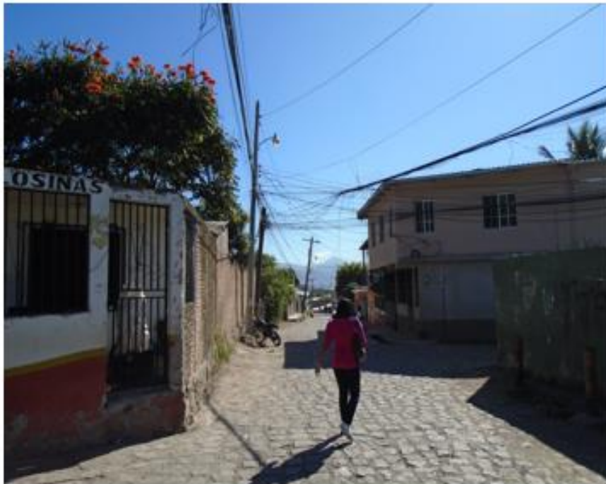
Inicio de tramo a pavimentar con White Topping
