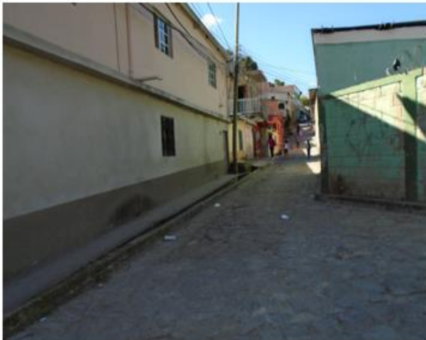
Panorama de tramo donde se construirán bordillos
