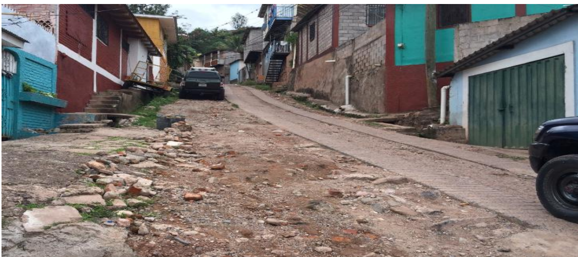
Foto 2: vista panoramica de calle tramo a.
