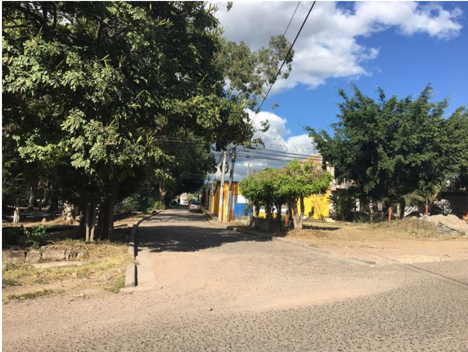
Inicio de tramo a pavimentar con White Topping
