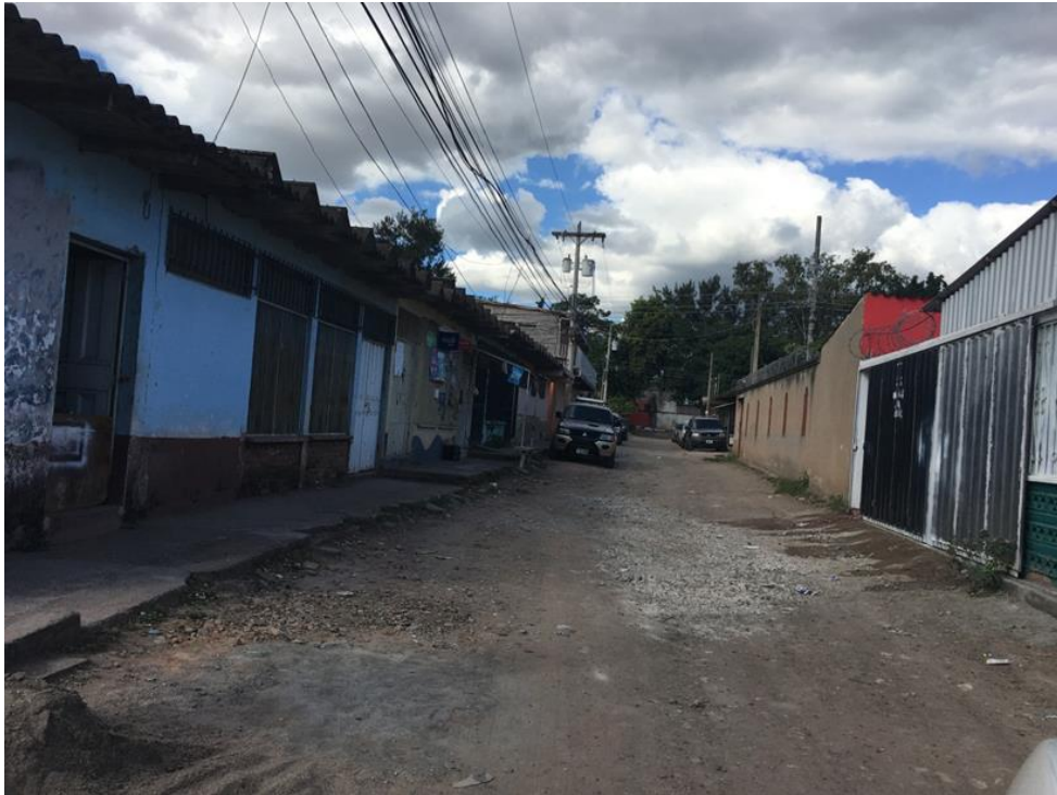
Vista de tramo a pavimentar con concreto hidráulico
