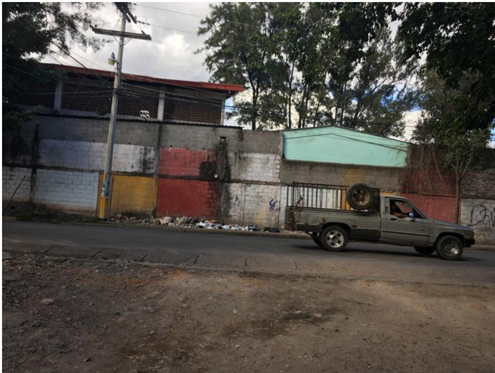
Final de tramo a pavimentar con concreto hidráulico
