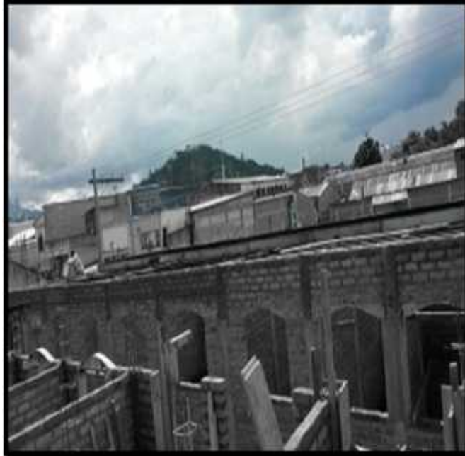
Demolición de elementos de concreto
