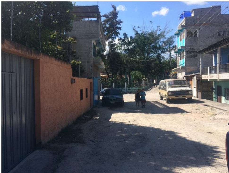
PANORAMA DE CALLE A PAVIMENTAR CON CONCRETO HIDRÁULICO
