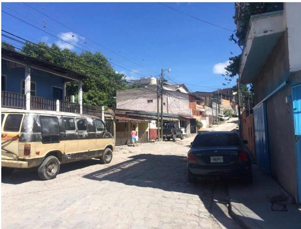
PANORAMA DE CALLE A PAVIMENTAR CON WHITE TOPPING
