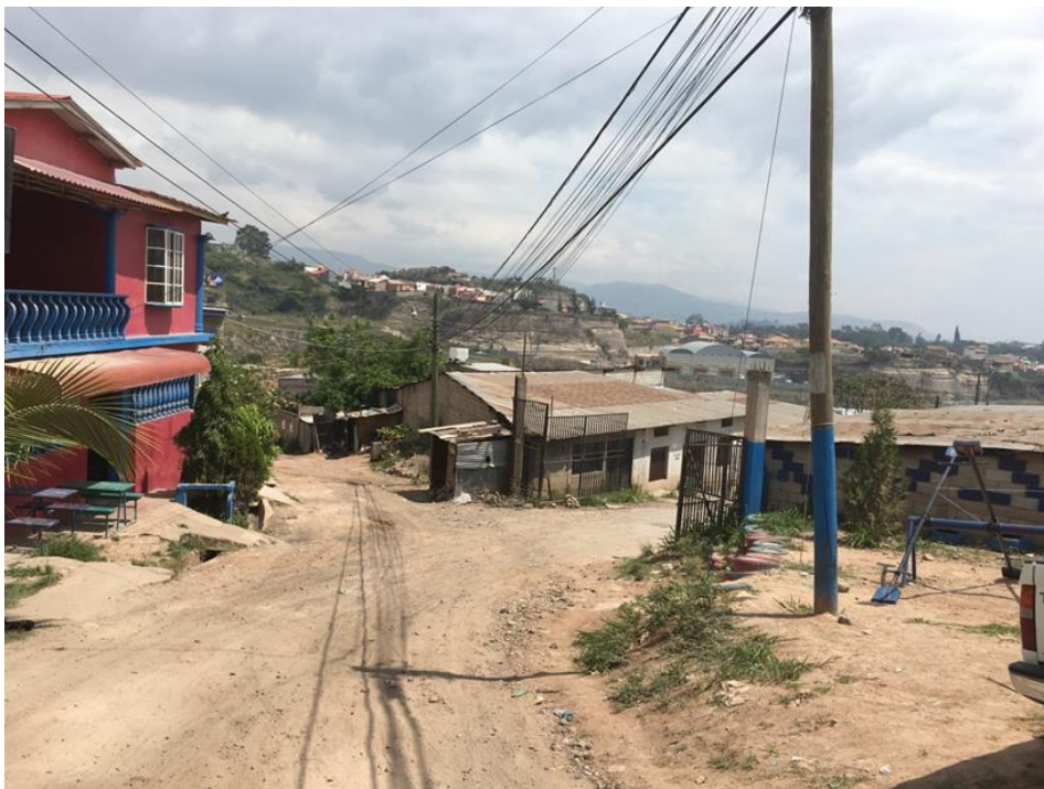
Final de calle a pavimentar
