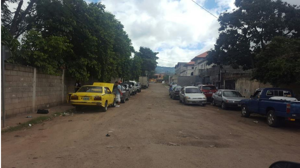
VISTA DE CALLE A PAVIMENTAR
