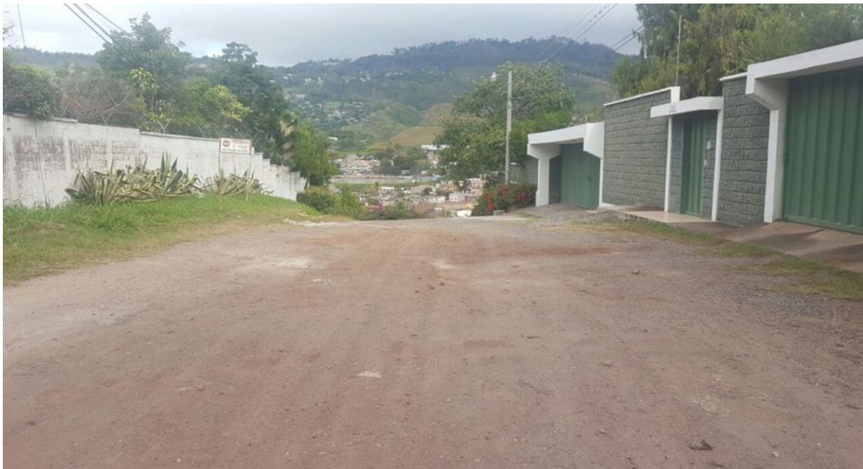
VISTA DE CALLE A PAVIMENTAR CON CONCRETO HIDRAULICO
