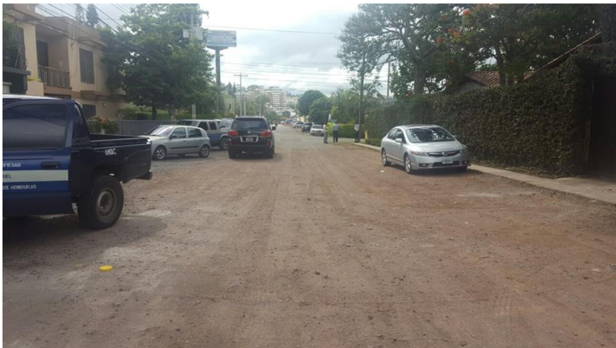
VISTA DE CALLE A PAVIMENTAR
