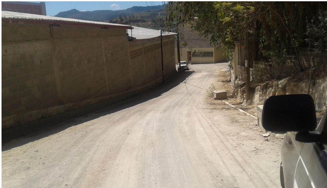
FOTO No 3 VISTA DE LA CALLE MICRO-CARPETA
