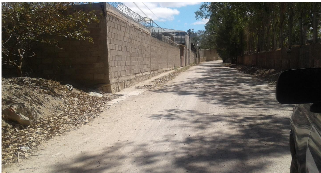
Foto No. 4 PAVIMENTACION DE CALLE MICROCARPETA
