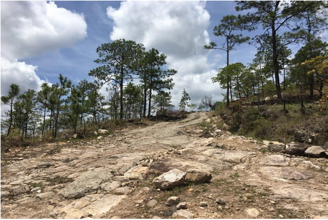
VISTA PANORAMICA DEL ESTADO DE LA CALLE
