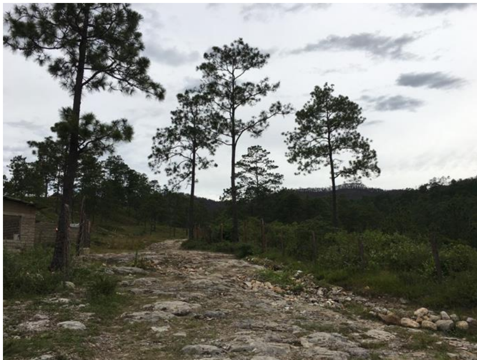
SITIO DONDE FINALIZAN LAS HUELLAS DE CONCRETO
