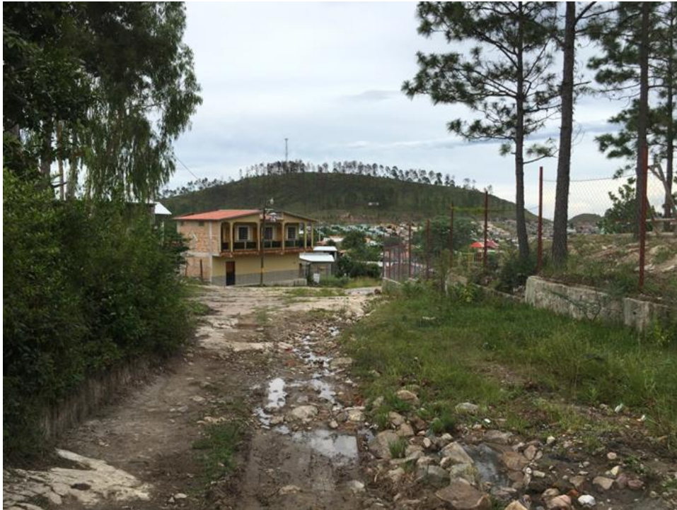
SE OBSERVAN LOS PROBLEMAS DE DRENAJE QUE DAÑAN LA CALLE
