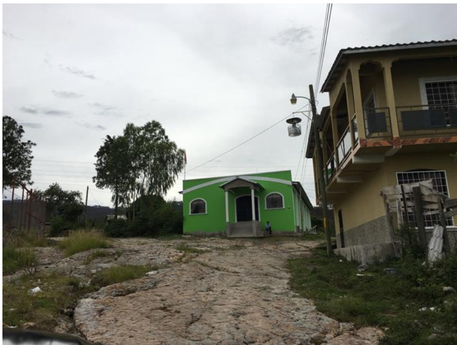
CONDICIONES ACTUALES DE LA CALLE A INTERVENIR CON EL PROYECTO EN LA COMUNIDAD DE BUENA VISTA
