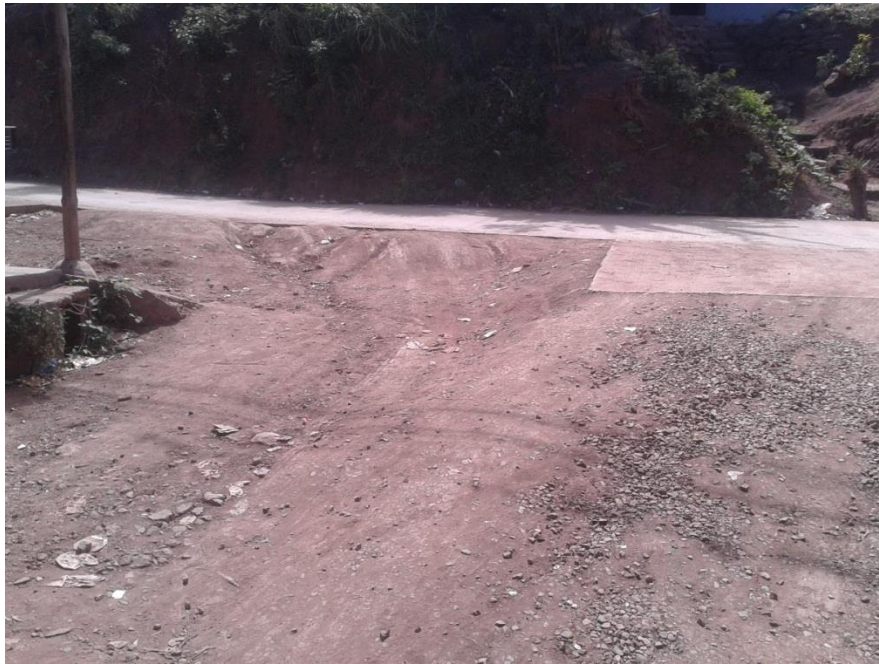
INICIO DE TRAMO CONCRETO HIDRÁULICO
