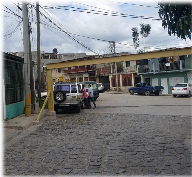
FINAL DE CALLE A PAVIMENTAR CON WHITE TOPPING
