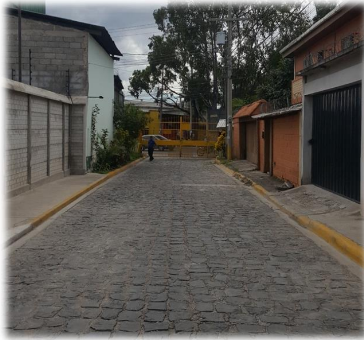
INICIO DE CALLE A PAVIMENTAR CON WHITE TOPPING
