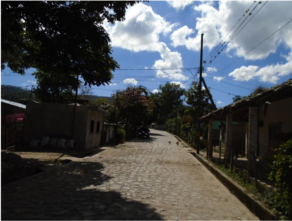
Vista de tramo a pavimentar con white topping
