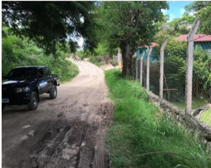
PANORÁMA DE CALLE EN QUE SE EJECUTARÁ LA OBRA
