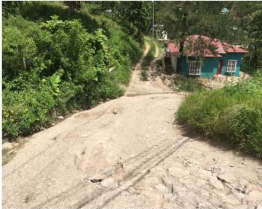
PANORÁMA DE CALLE EN QUE SE EJECUTARÁ LA OBRA
