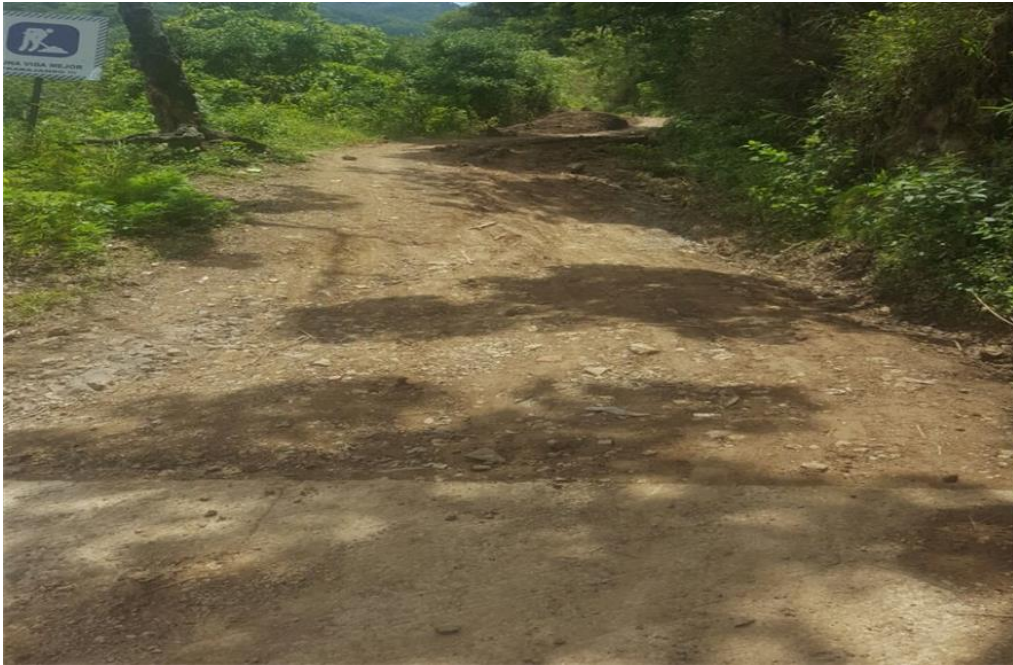
VISTA DEL INICIO DEL TRAMO HUELLAS
