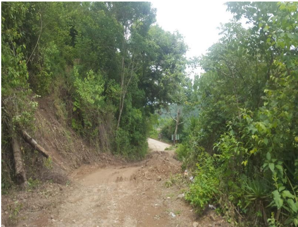
VISTA DEL TRAMO INSTALACION DE ALCALTARILLA
