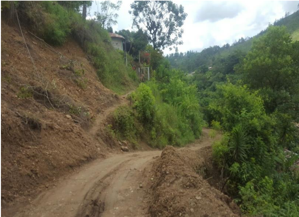
VISTA DEL TRAMO INSTALACION DE ALCALTARILLA
