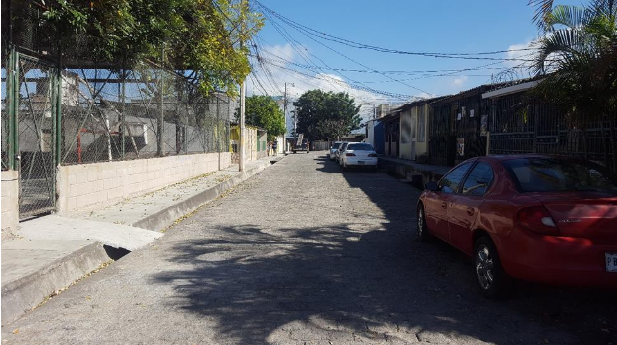
Calle a pavimentar con concreto hidráulico tramo 3
