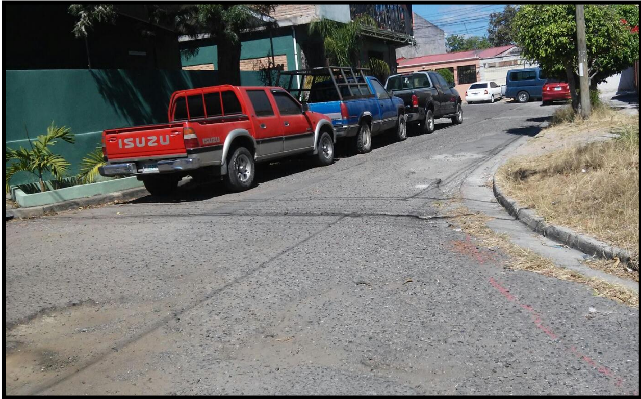
VISTA PANORAMICA DEL TRAMO EN MAL ESTADO
