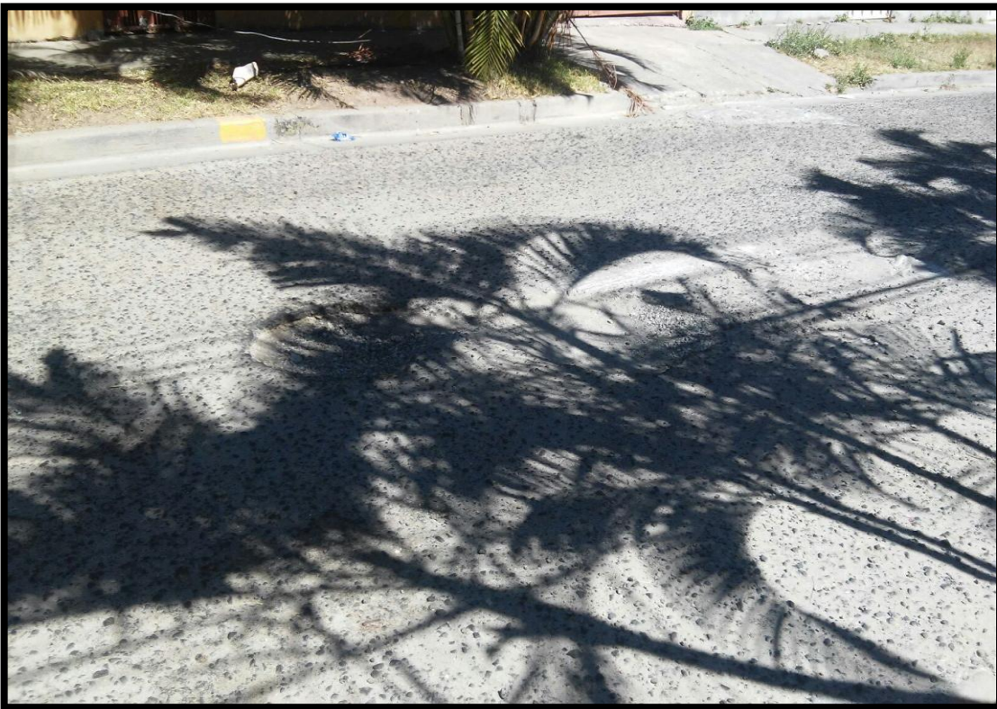
VISTA DE CALLES A REHABILITAR
