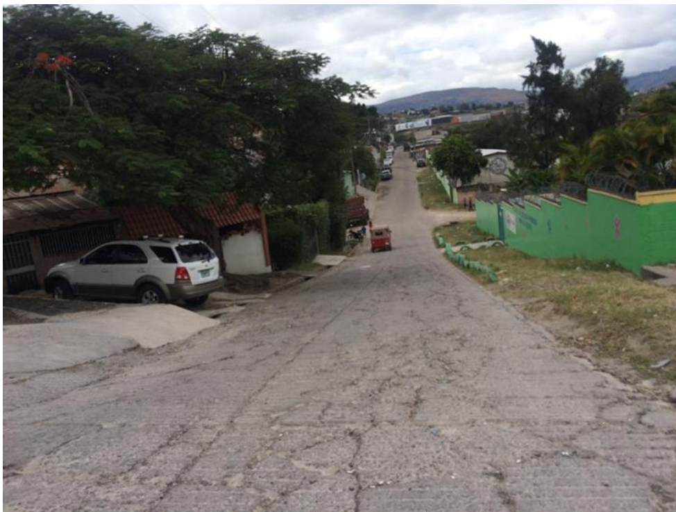
Vista hacia el final de calle a pavimentar
