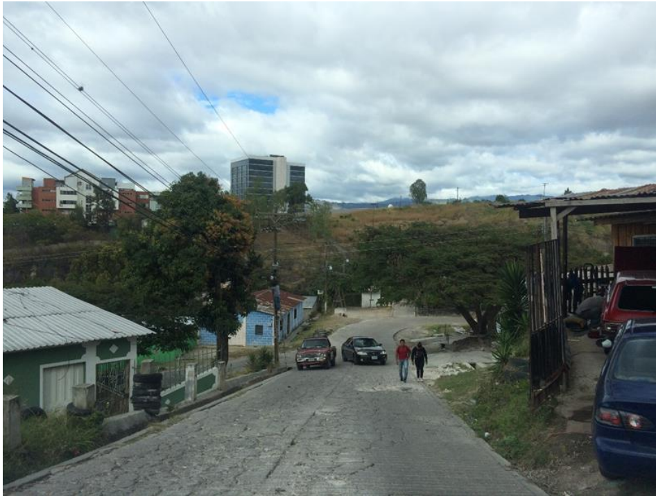
Calle donde se demolerá la losa existente
