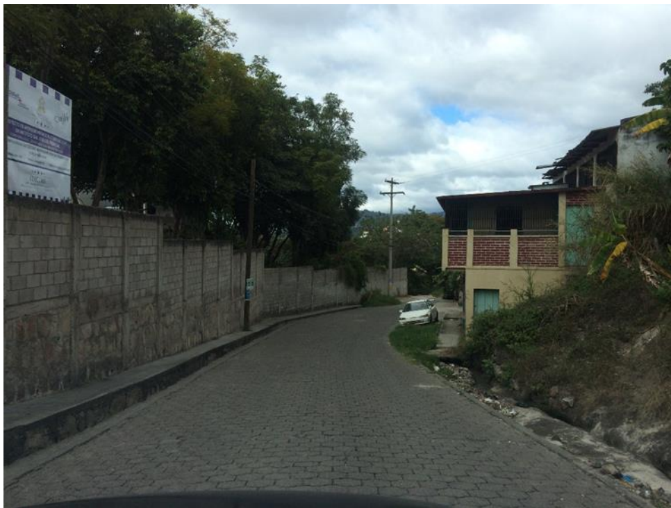
Vista del tramo donde se desmontara el adoquin
