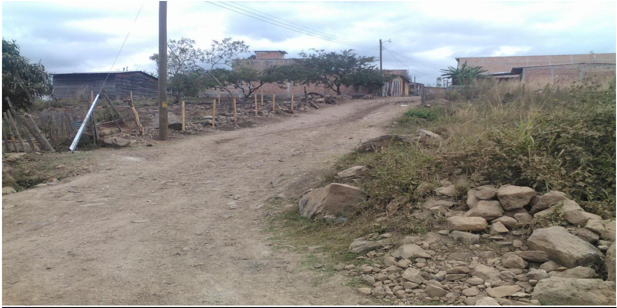
FOTO NO 1 Col. Brisas del Mogote Vista del Conformado y Balastado de Calles
