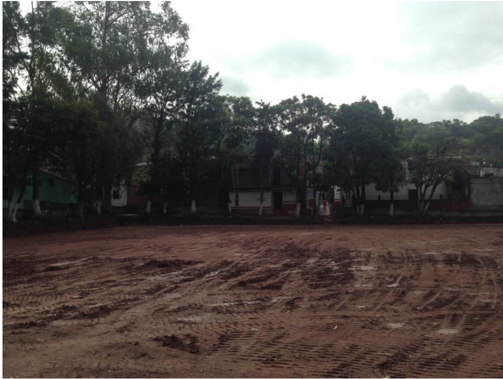
Vista panorámica de estacionamiento
