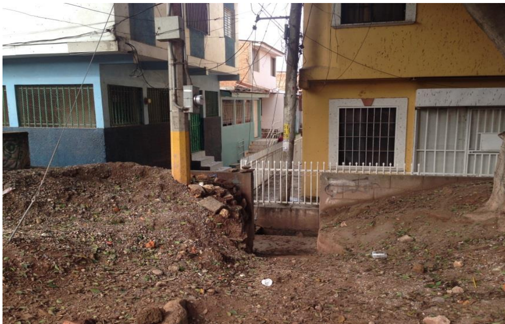
Vista de acceso peatonal a estacionamiento
