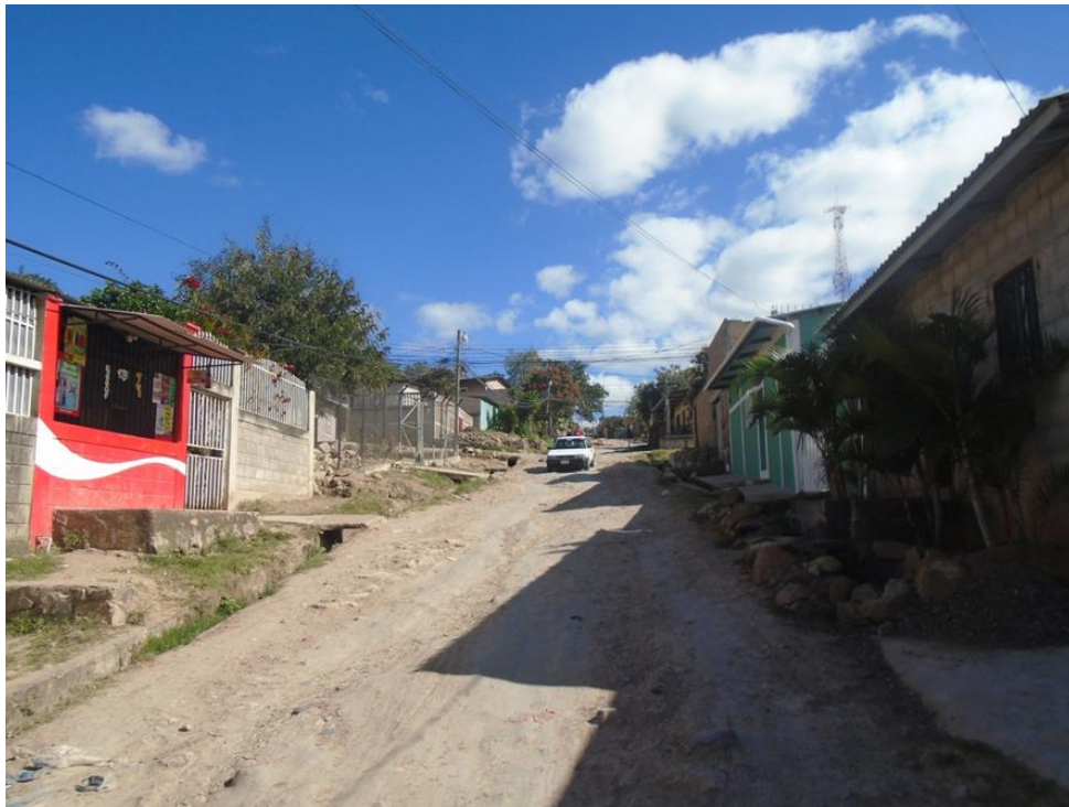
Panorama de calle a pavimentar
