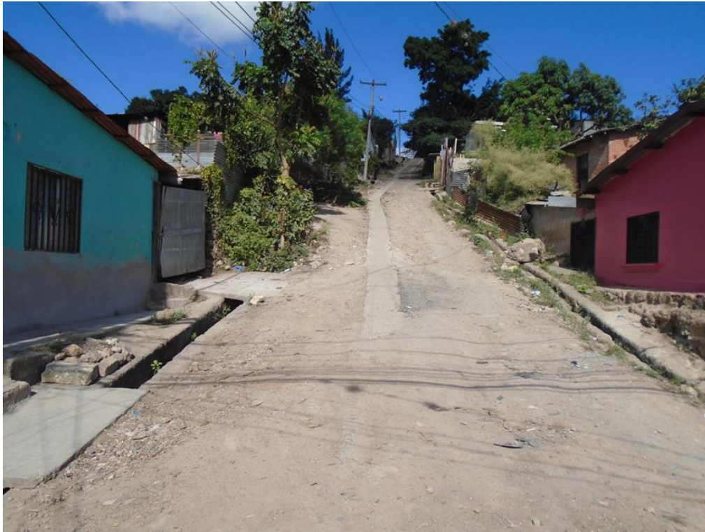
Inicio de calle a pavimentar
