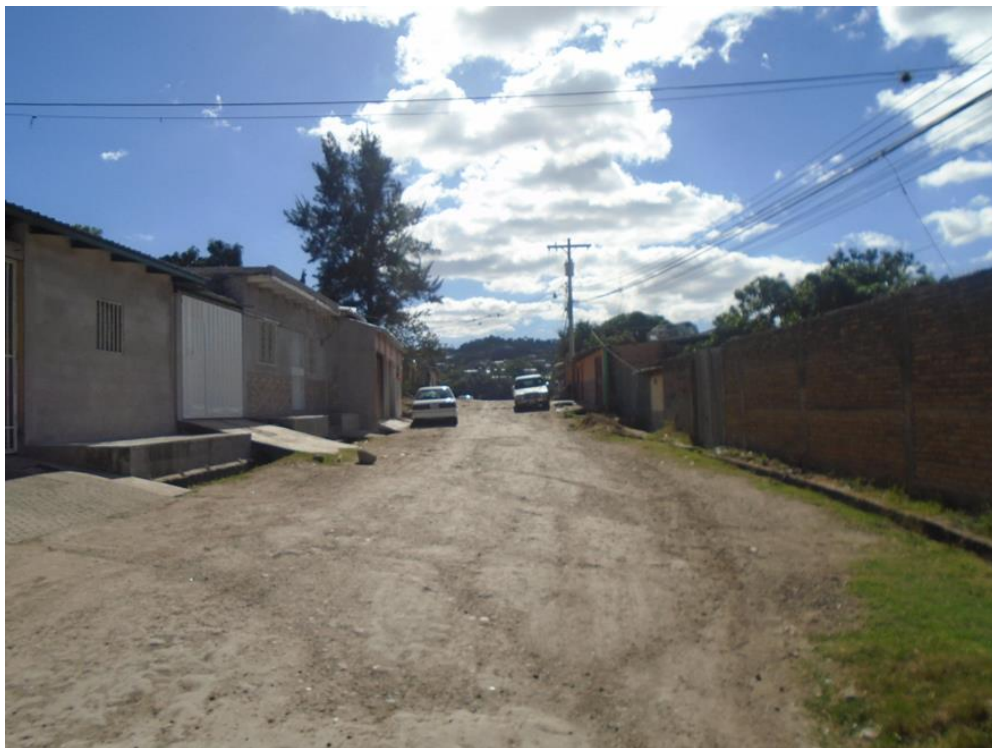
Final de calle a pavimentar
