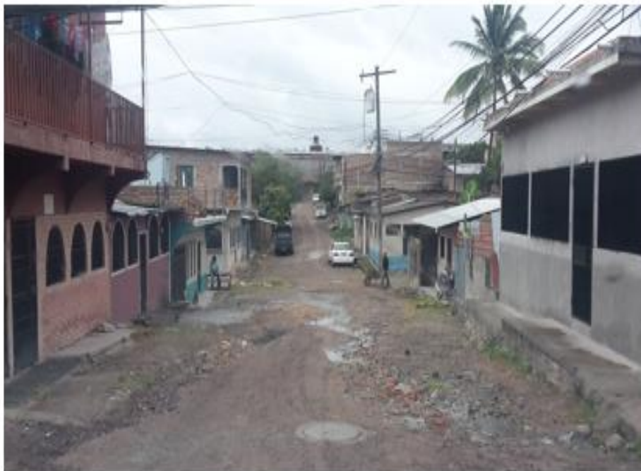
Panorama de calle a pavimentar
