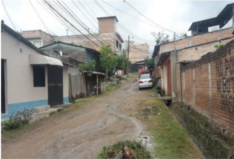
Vista del estado de calle
