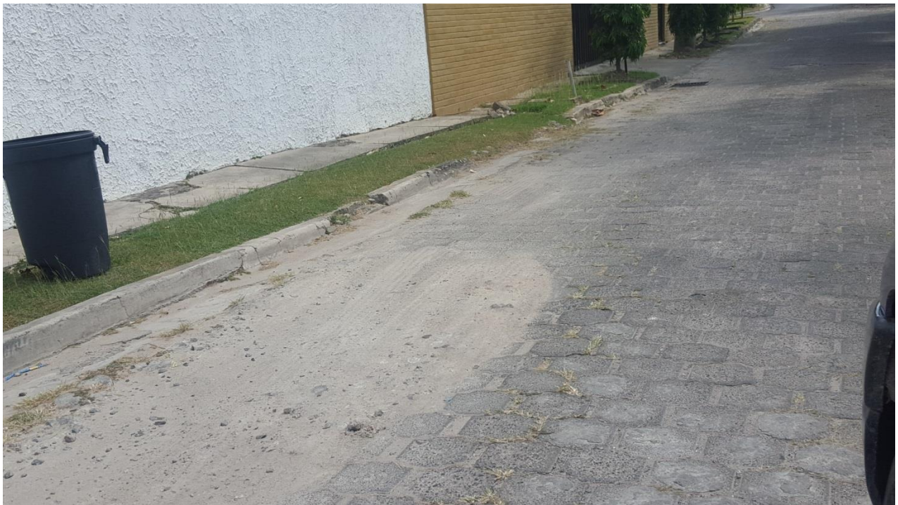
Sección de tramo a reparar
