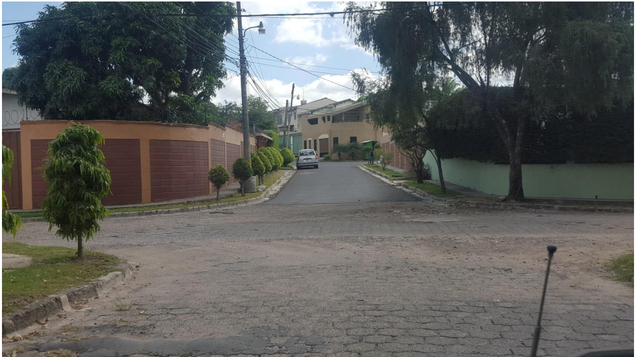
Inicio de tramo a pavimentar
