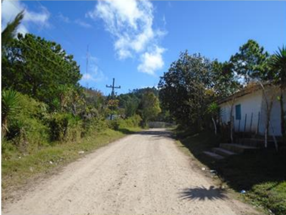
VISTA DEL MAL ESTADO DE LA CALLE
