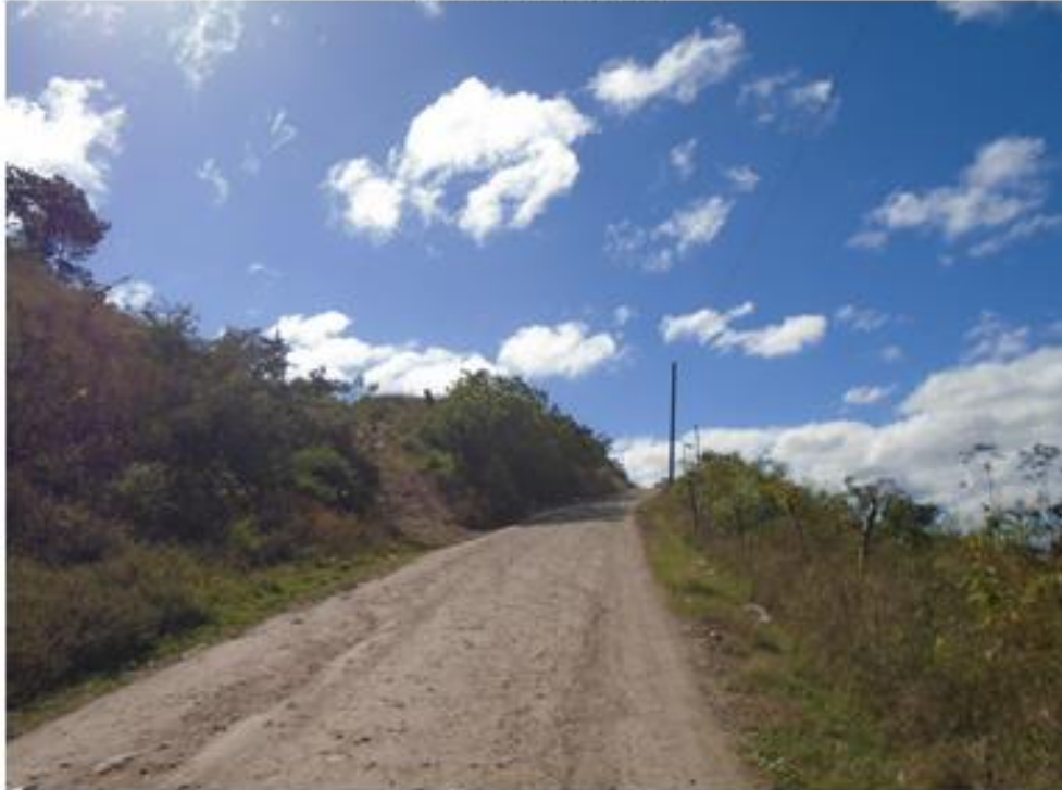
VISTA PANORÁMICA DE LA CALLE A REPARAR
