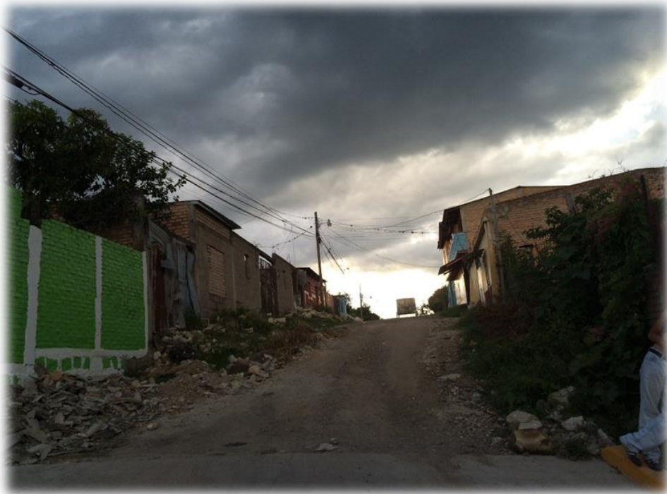
INICIO DE PAVIMENTACION
