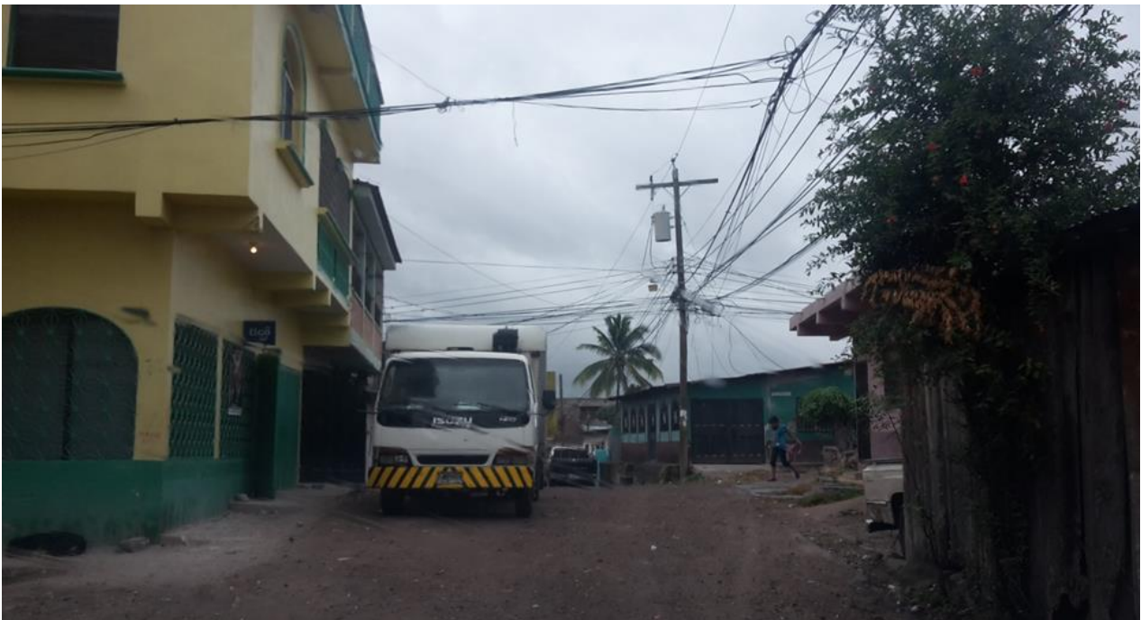
PANORAMA DE CALLE A PAVIMENTAR CON CONCRETO HIDRAULICO
