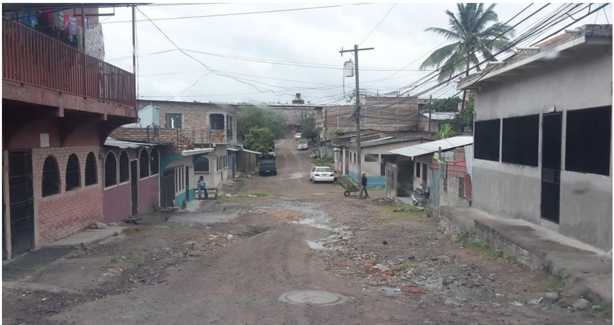
VISTA DE CALLE A PAVIMENTAR CON CONCRETO HIDRAULICO
