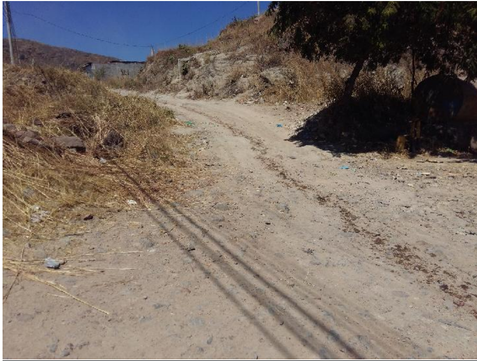
Tramo a balastar cerca de Cerro Grande zona 2
