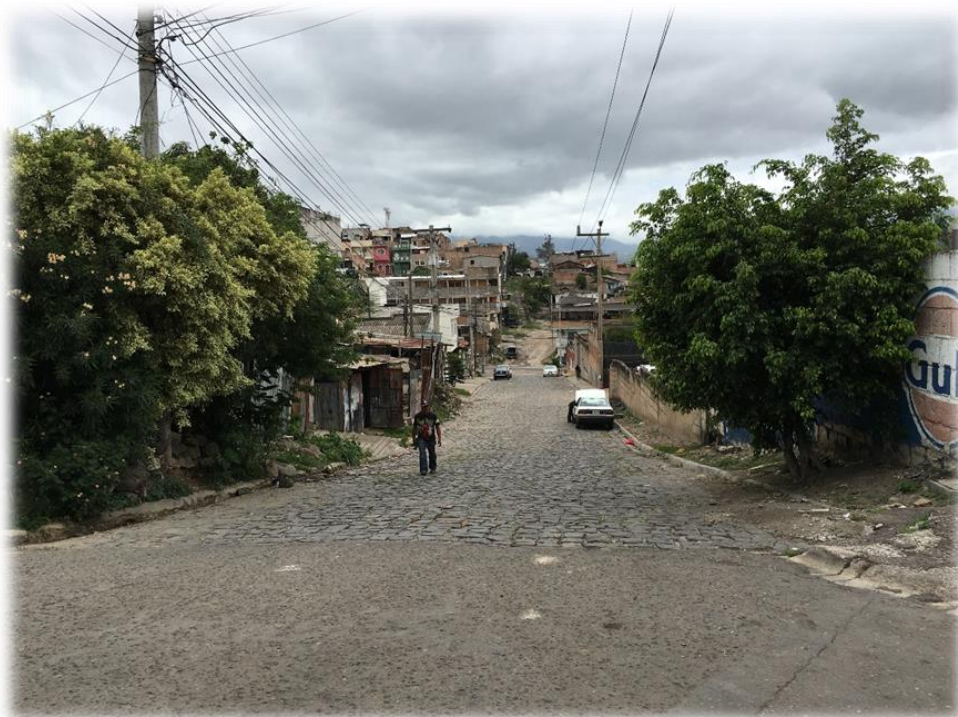
VISTA DE CALLE A PAVIMENTAR CON WHITE TOPPING
