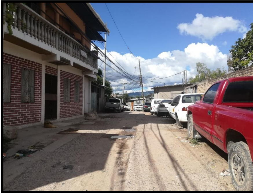
No.1 Vista inicio calle 1 alcantarillado sanitario.
