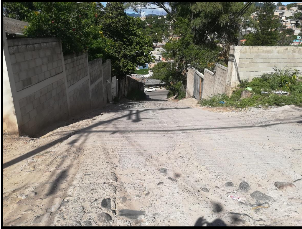
No.3 Tramo final calle 1, al fondo se observa la carretera a Danli, donde se encuentra el pozo de inspección existente al cual se conectará el proyecto.
