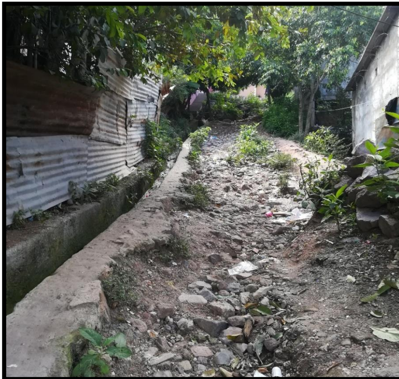
No.6 Vista del tramo final de calle 3.
