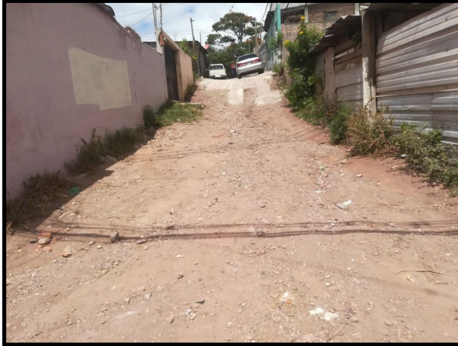
No.1 Inicio de calle 1 a pavimentar, ancho promedio 4.70 m
