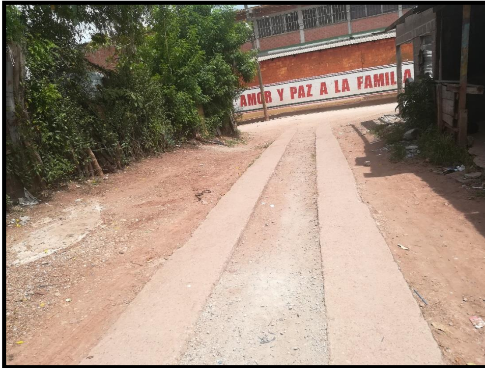
No.3 Final de calle 2 a pavimentar, se conectara al pavimento existente.
