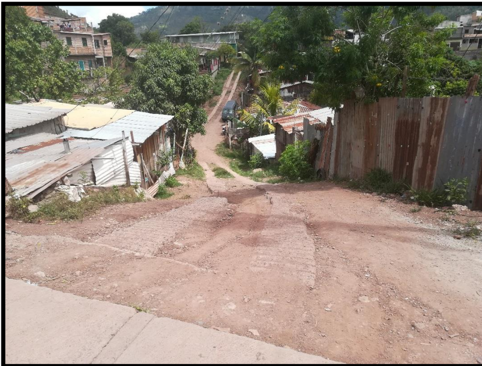
No.2 Inicio de calle 2 a pavimentar, longitud total 120 m .
