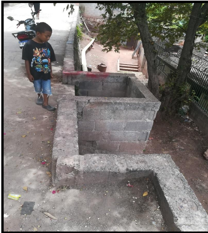
No.4 Vista general donde se instalara el pasamanos, también se observa el tragante a tapar.
