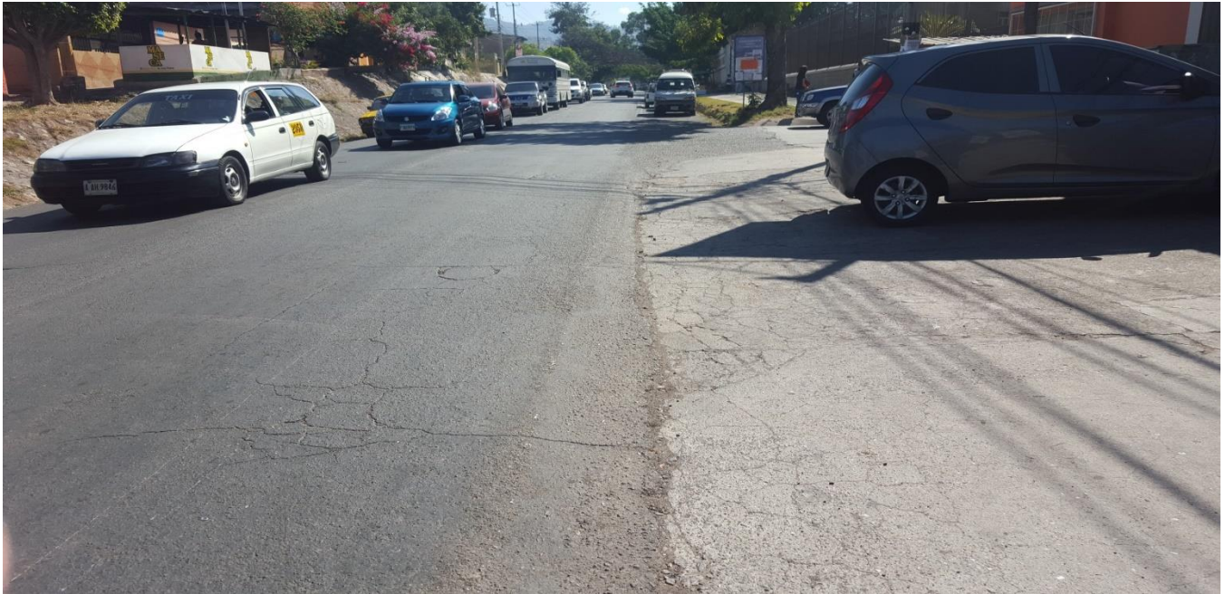
VISTA DE TRAMO EN LA PRIMERA ENTRADA
