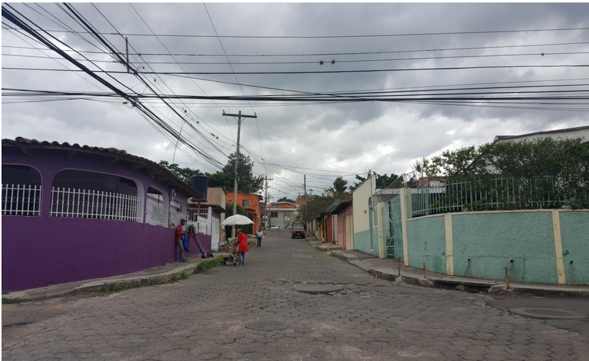
VISTA DE CALLE A PAVIMENTAR CON CONCRETO HIDRÁULICO
