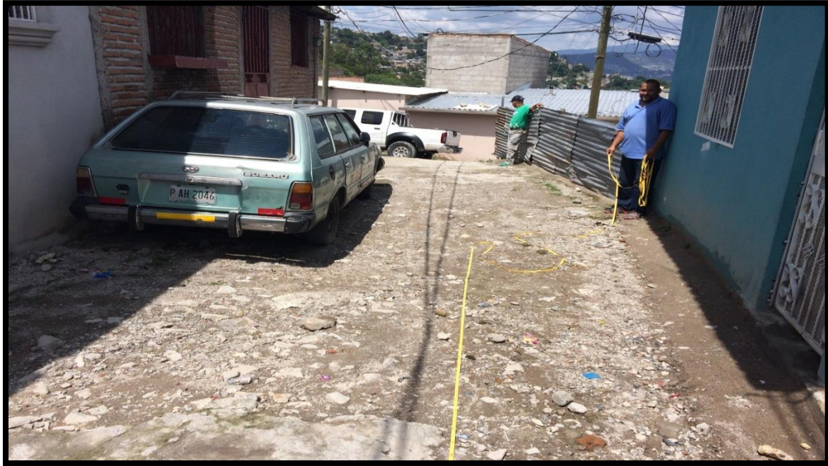
Vista de otro tramo de calle a pavimentar
