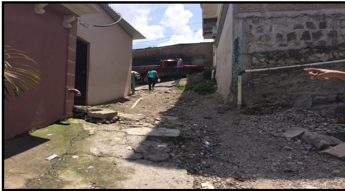
Inicio de calle a pavimentar
