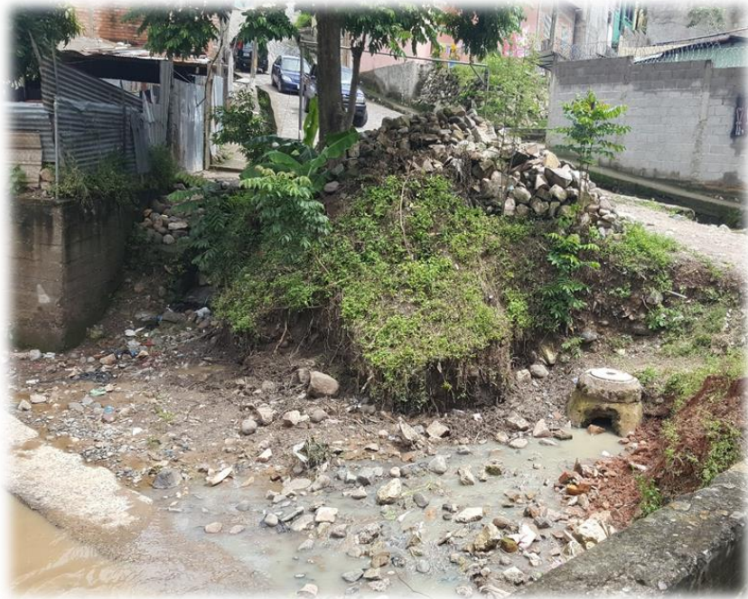
PANORAMA DE DONDE SE CONSTRUIRA EL MURO
