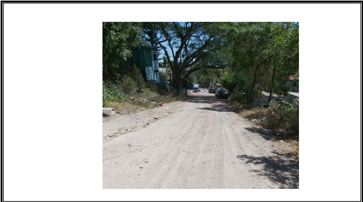
No. 2 VISTA DE ZONA DONDE SE CONSTRUIRA EL ALCANTARILLADO SANITARIO Y PAVIMENTO DE CONCRETO HIDRAULICO.
